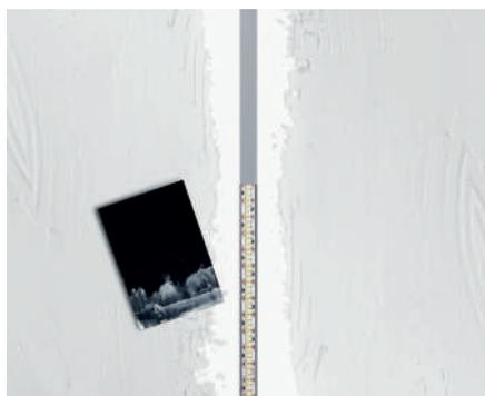
Una volta fissato, rasare per ottenere una superficie liscia. La zona di rasatura distante dall'alloggiamento della strip LED rende più sicuro e facile questo passaggio.
